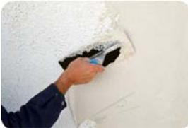
Mortero seco fibroreforzado, producido en fabrica a partir de ligantes hidráulicos de cal, silices seleccionados redondeados, cemento, fibras de vidrio y resinas deshidratadas, para la perfecta aplicación manual.
